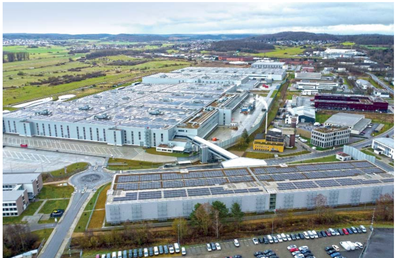
VGP Park Giessen Am Alten Flughafen
