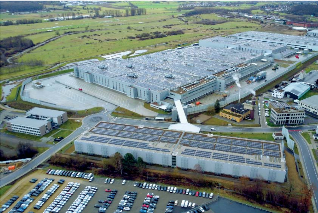
VGP Park Giessen Am Alten Flughafen
