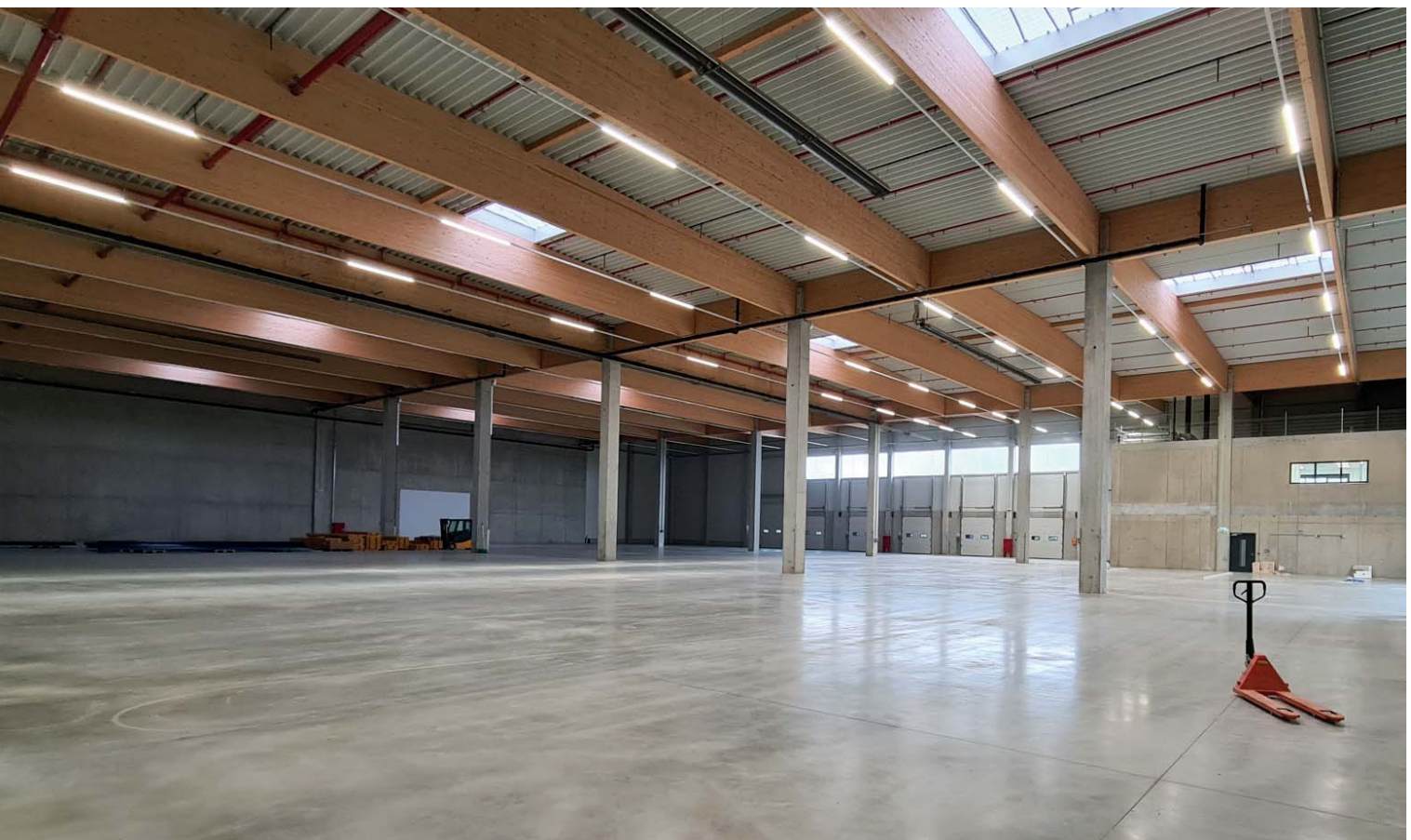
Houten draagstructuur in VGP Park Graz
