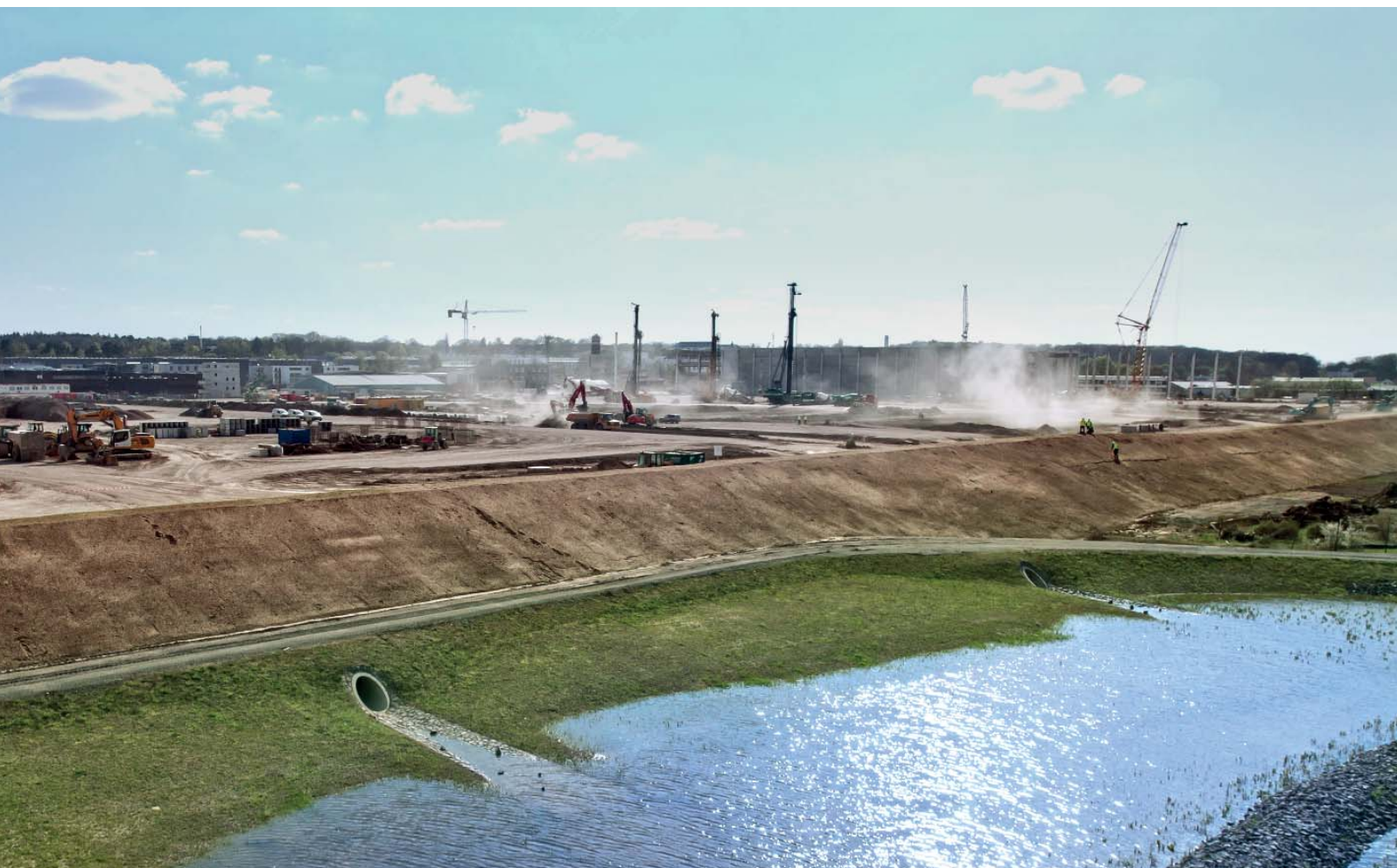
Waterretentiebekken en werken in Giessen Am Alten Flughafen
