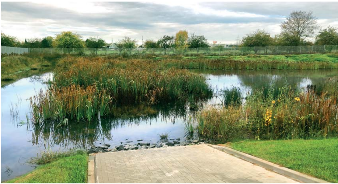
Waterretentiebassin in VGP Park Laatzen
