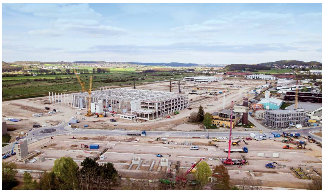
Works at VGP Park Giessen Am Alten Flughafen
