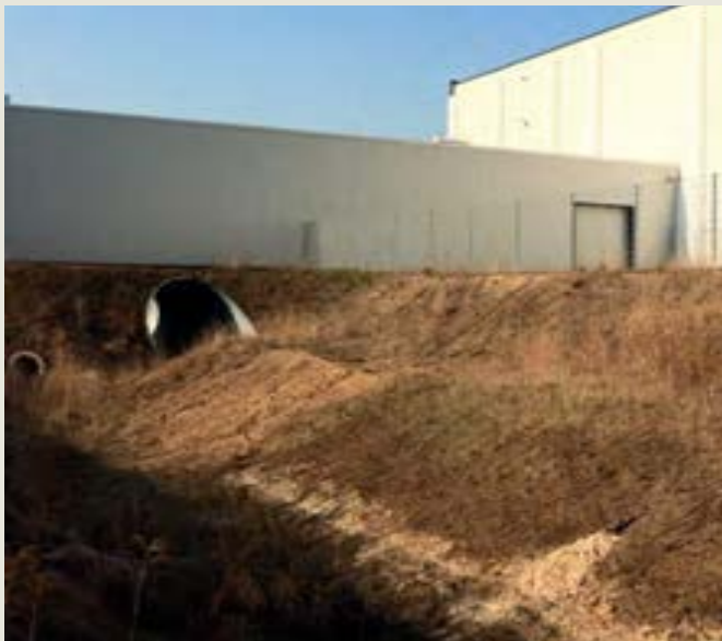
VGP Park Berlijn – Watergoten om overtollig regenwater vast te houden en ecoduct
