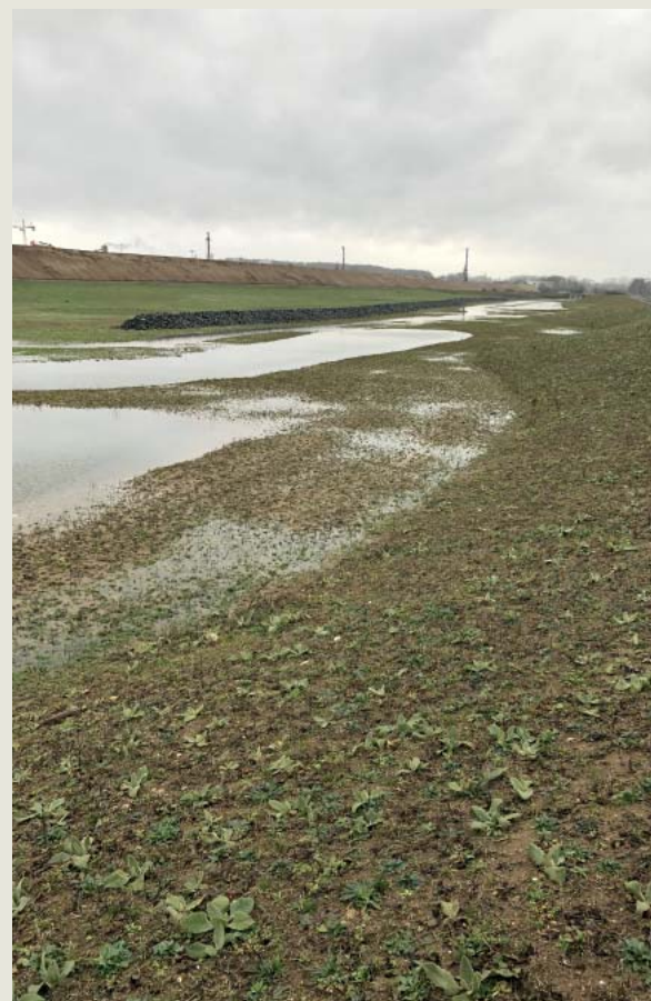
VGP Park Gießen am Alten Flughafen – rain water retention basin
