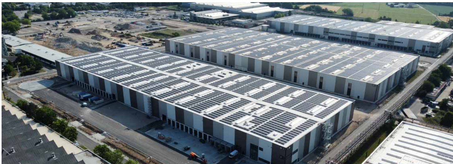
VGP Park Wiesloch-Walldorf, Germany
